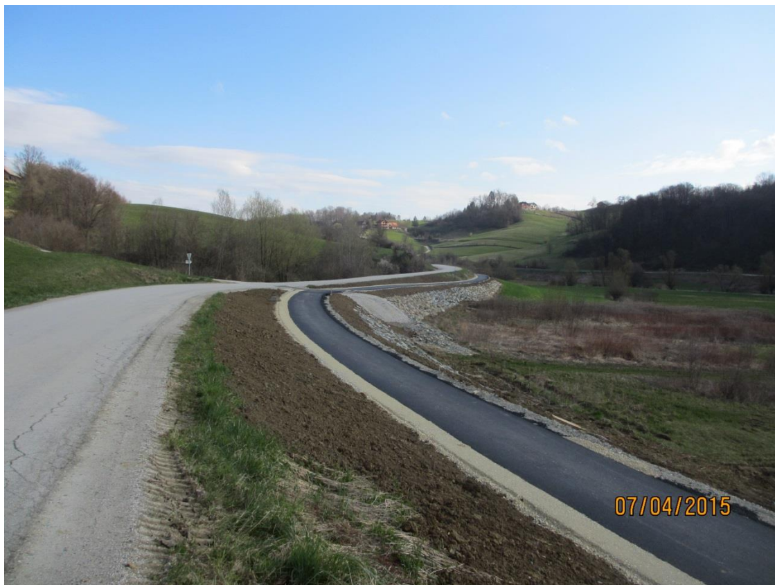
Slika 1: Gradbišče 7.4.2015 Kolesarka Podčetrtek odsek 3-1
